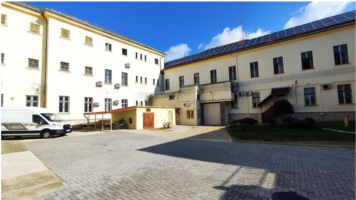
A bv. intézet felújított díszkőburkolatú udvara
