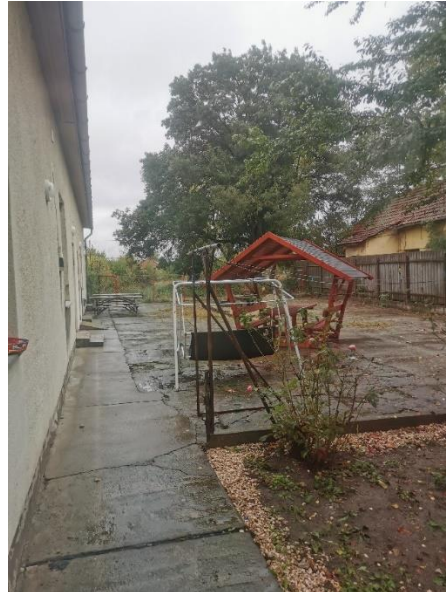
8. kép Udvar új padok és a töredezett beton
