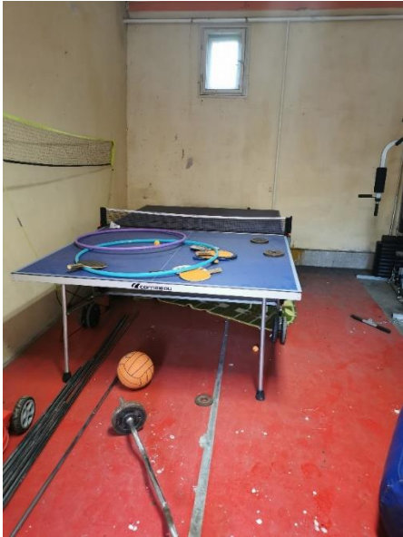
7. kép A felújítás alatt álló sportszoba
