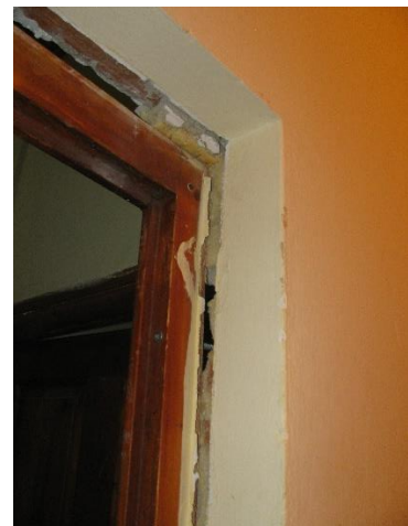
7-9. kép Rongálásnyomok az ajtón, a ház falán, kiszakított ajtófélfá
