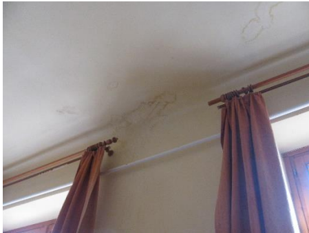
5. kép Beázásnyomok
