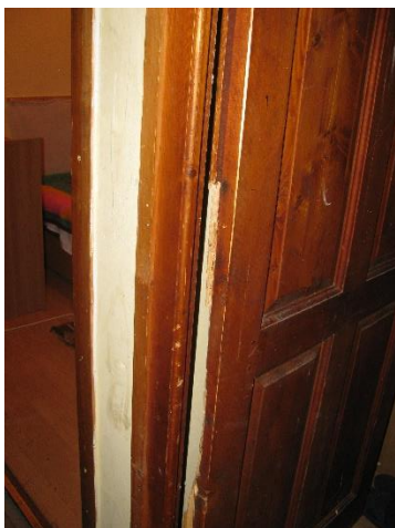
7-9. kép Rongálásnyomok az ajtón, a ház falán, kiszakított ajtófélfá
