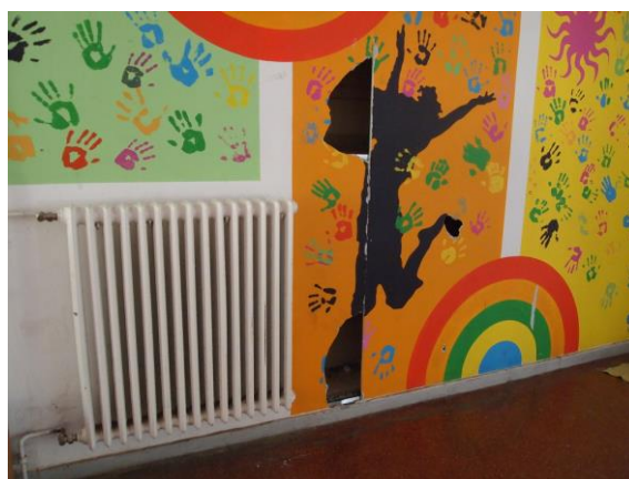
8. sz. kép. Beszakított fal a csoporthelyiségekben
