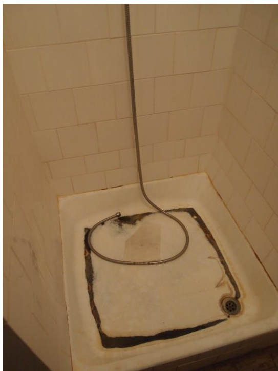
7. kép: Rozsda és vízkő a zuhanyzó tálcában
