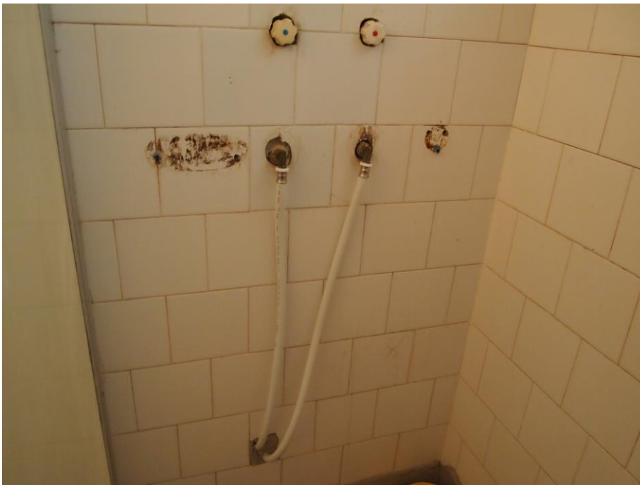
10. kép: Zuhanycsap cső és rózsza nélkül
